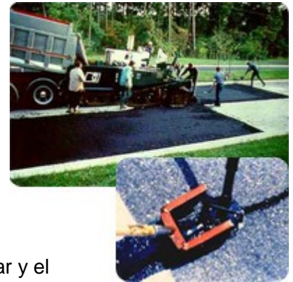
Preparación de la Superficie
