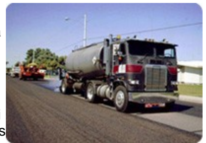
Aplicación por Pulverización
