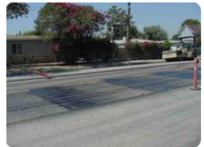
Imprimación deficiente
