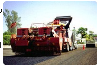
Aplicación de Agregado
