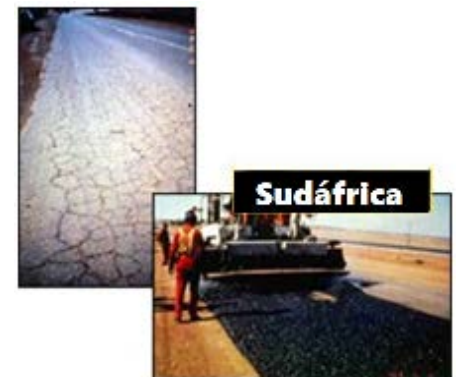
Investigación de Condiciones Originales del Pavimento de 1992 para el HVS
