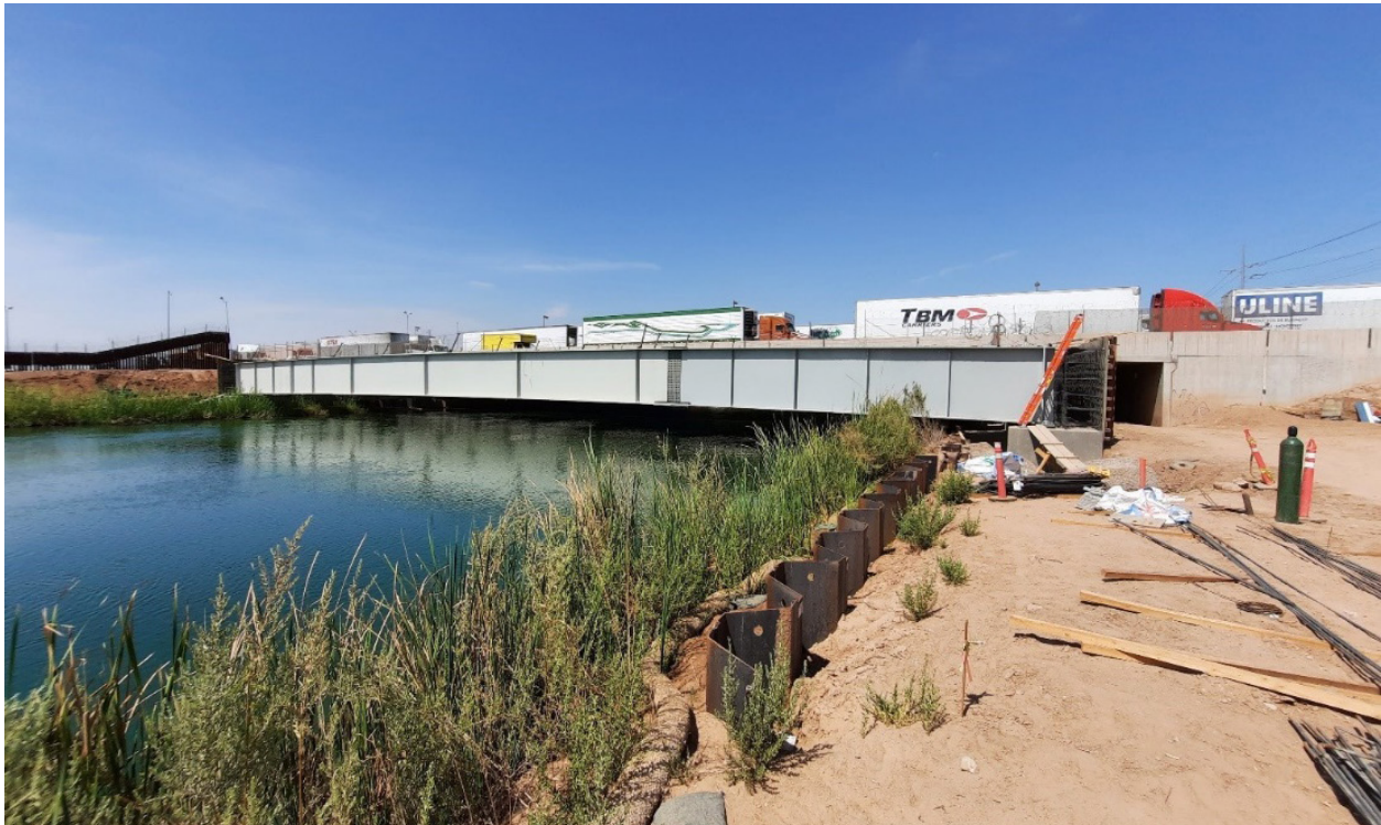
Imagen 8. Ampliación del Puente de Calexico
